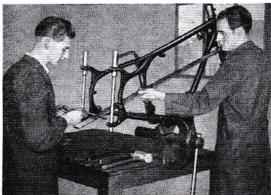
Fluchtdorne, Schiebelehre und Lineal, die Werkzeuge beim Ausfluchten (Bild 2)
